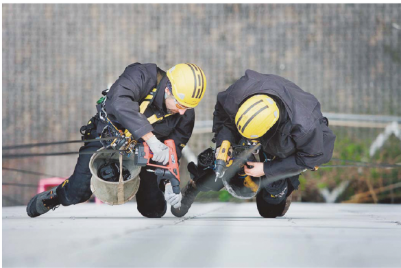
Schwindelfrei: Fassadenkletterer reparieren die Sozialstation in Bockenheim.
